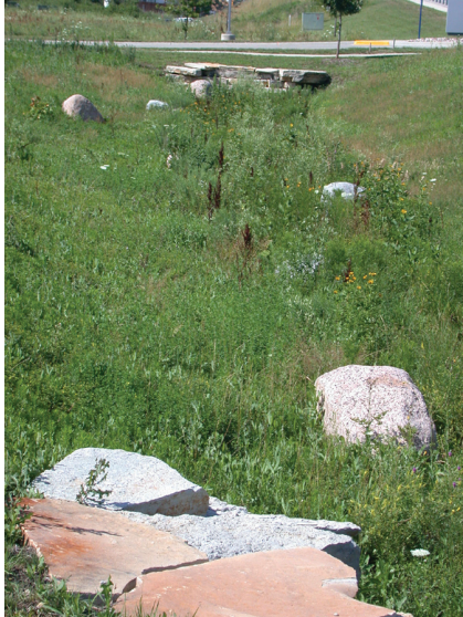
Fig. D1-4: Overland Bioswale
